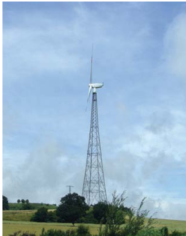
Kuva 3-6 Ristikkorakenteinen torni.
