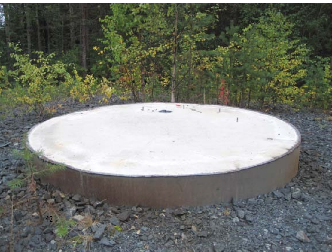
Kuva 6-3 Puretun voimalan perustukset.
