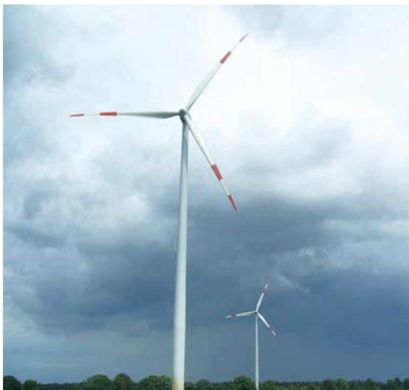
Kuva 3-7 Esimerkkikuva tuulivoimalan päivämerkinnöistä.
