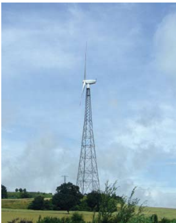
Kuva 6-6. Ristikkotorni
