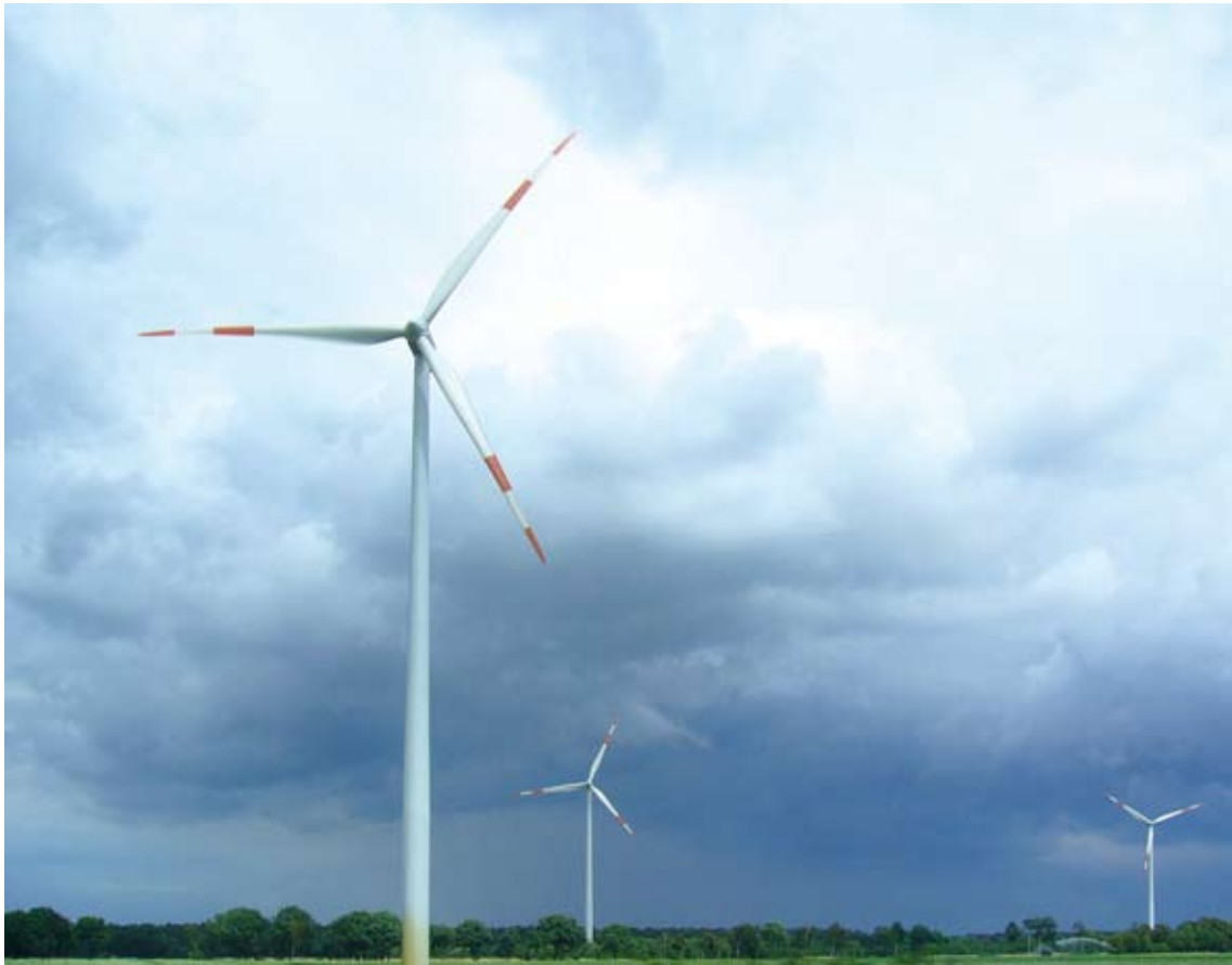
Kuva 6-7 Esimerkkikuva tuulivoimalan päivämerkinnöistä.
