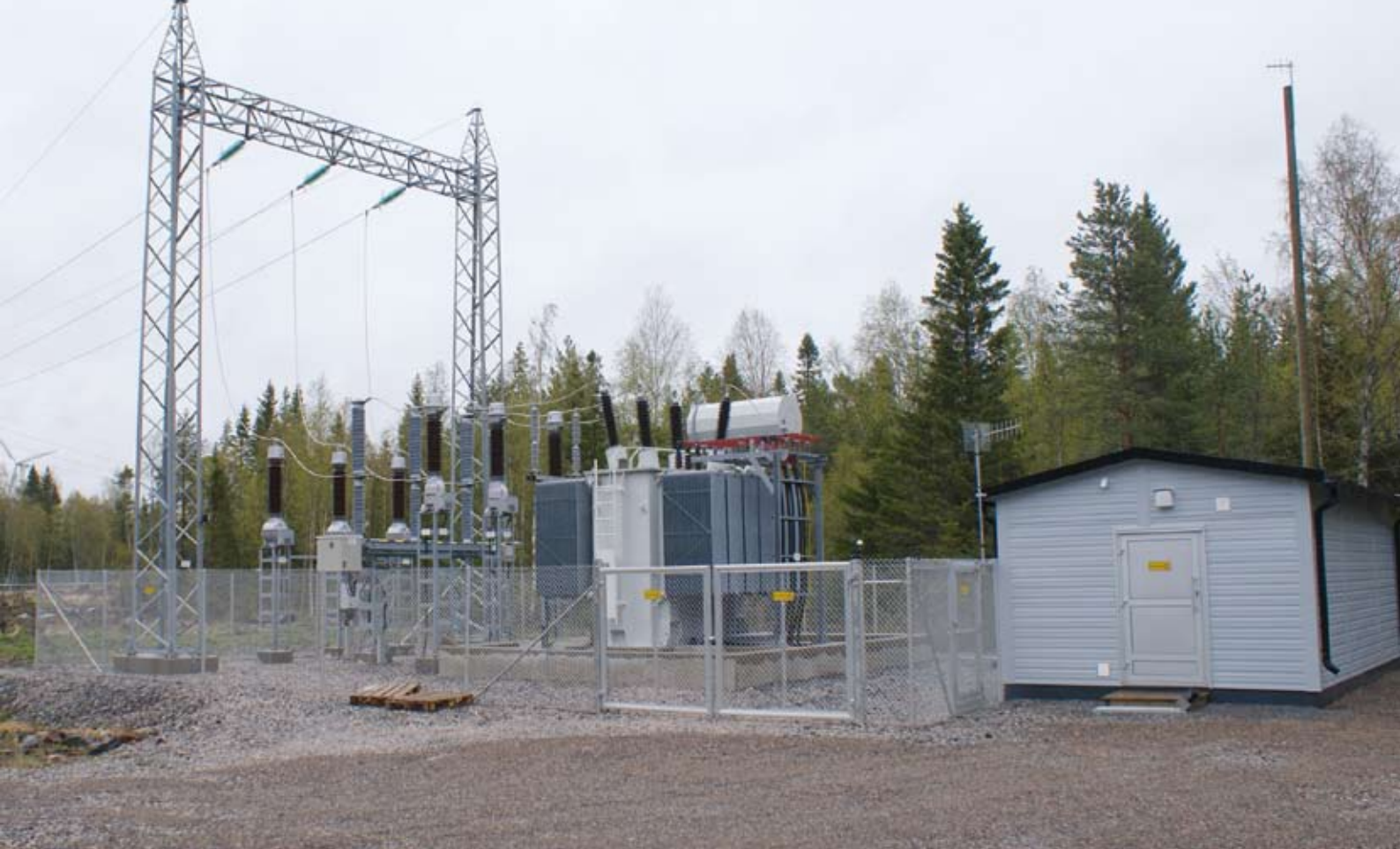
Kuva 6-12 Sähköaseman rakenne.
