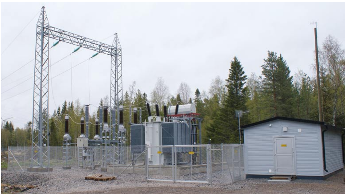
Figur 6-4 Exempel på en elstation.
