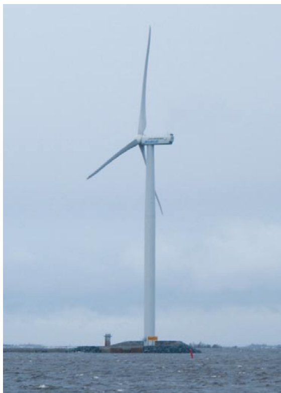
Figur 6-10 Rörformat torn.
