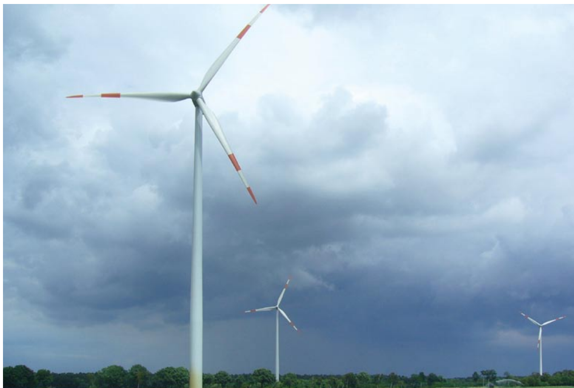
Figur 6-12 Exempel på dagmarkeringar på ett vindkraftverk.
