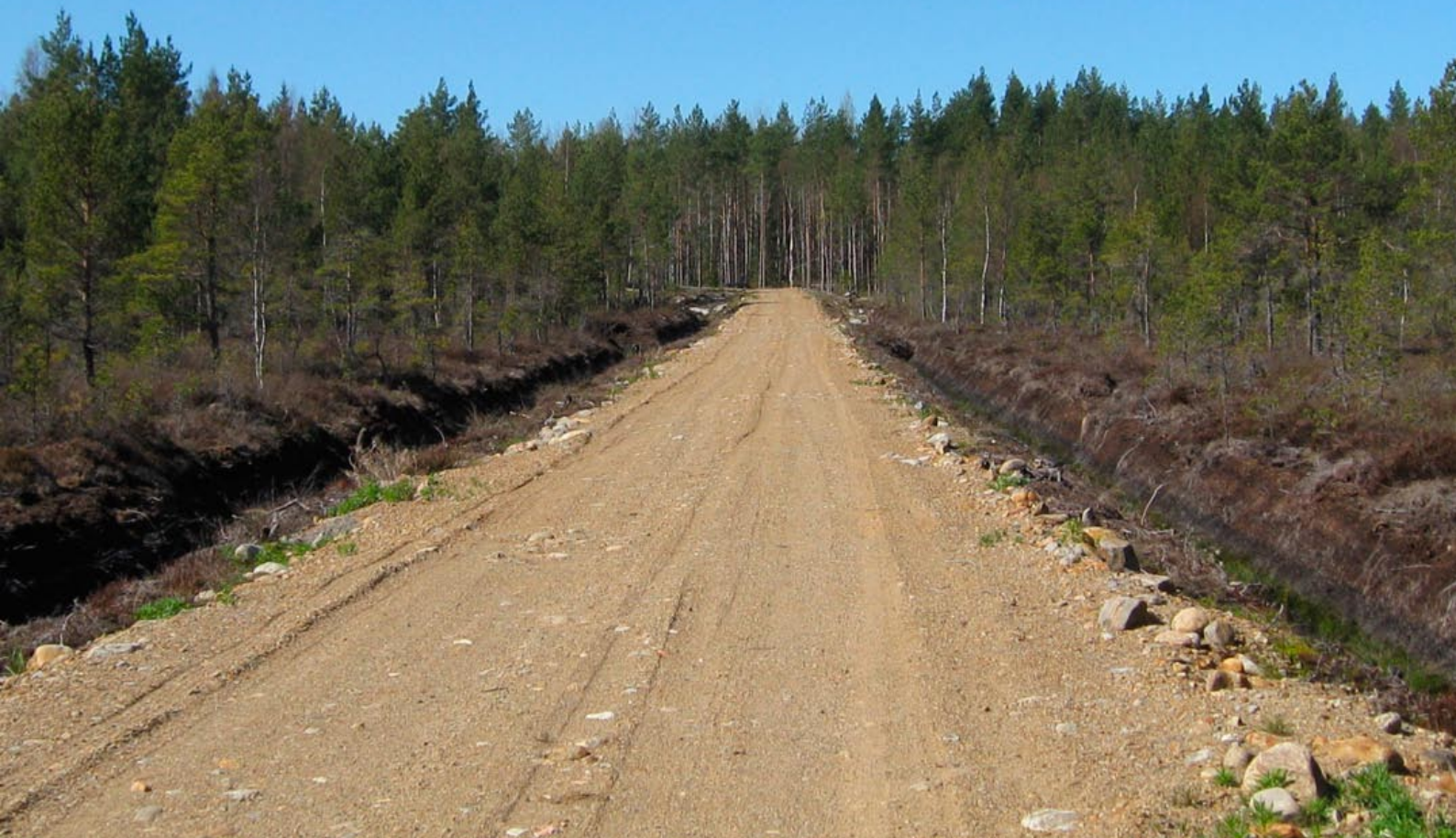
Figur 11-48 Ny skogsbilväg framför kraftverk 31 tvärs över Stensmosanneva.
