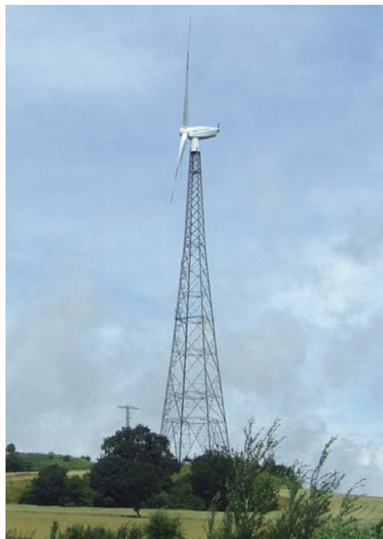
Figur 6-11 Torn av fackverkskonstruktion.
