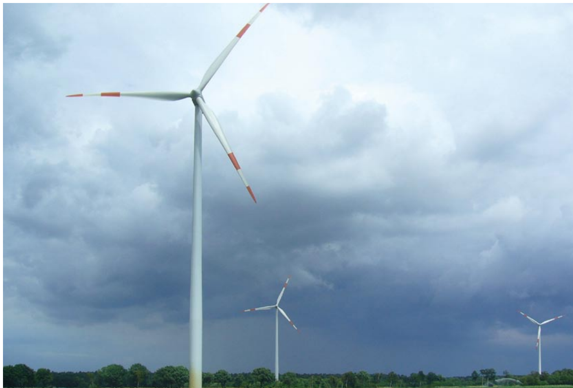
Kuva 6-12 Esimerkkikuva tuulivoimalan päivämerkinnöistä.
