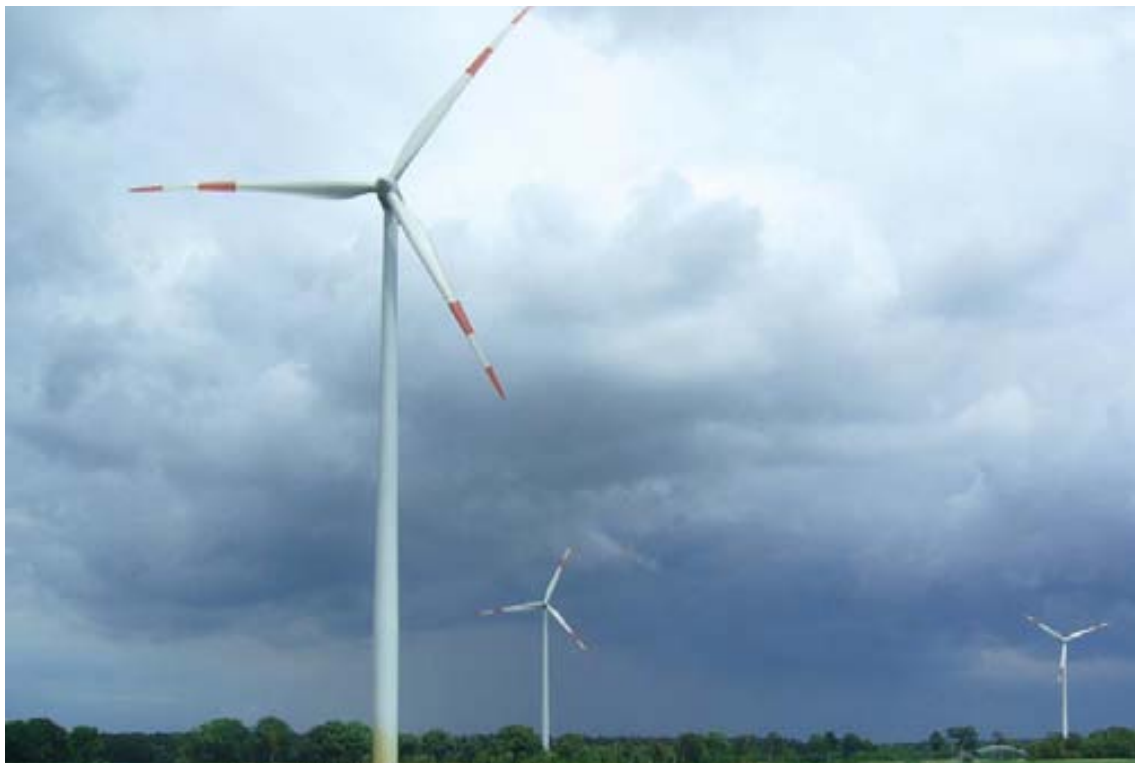
Kuva 6-10 Esimerkkikuva tuulivoimalan päivämerkinnöistä.
