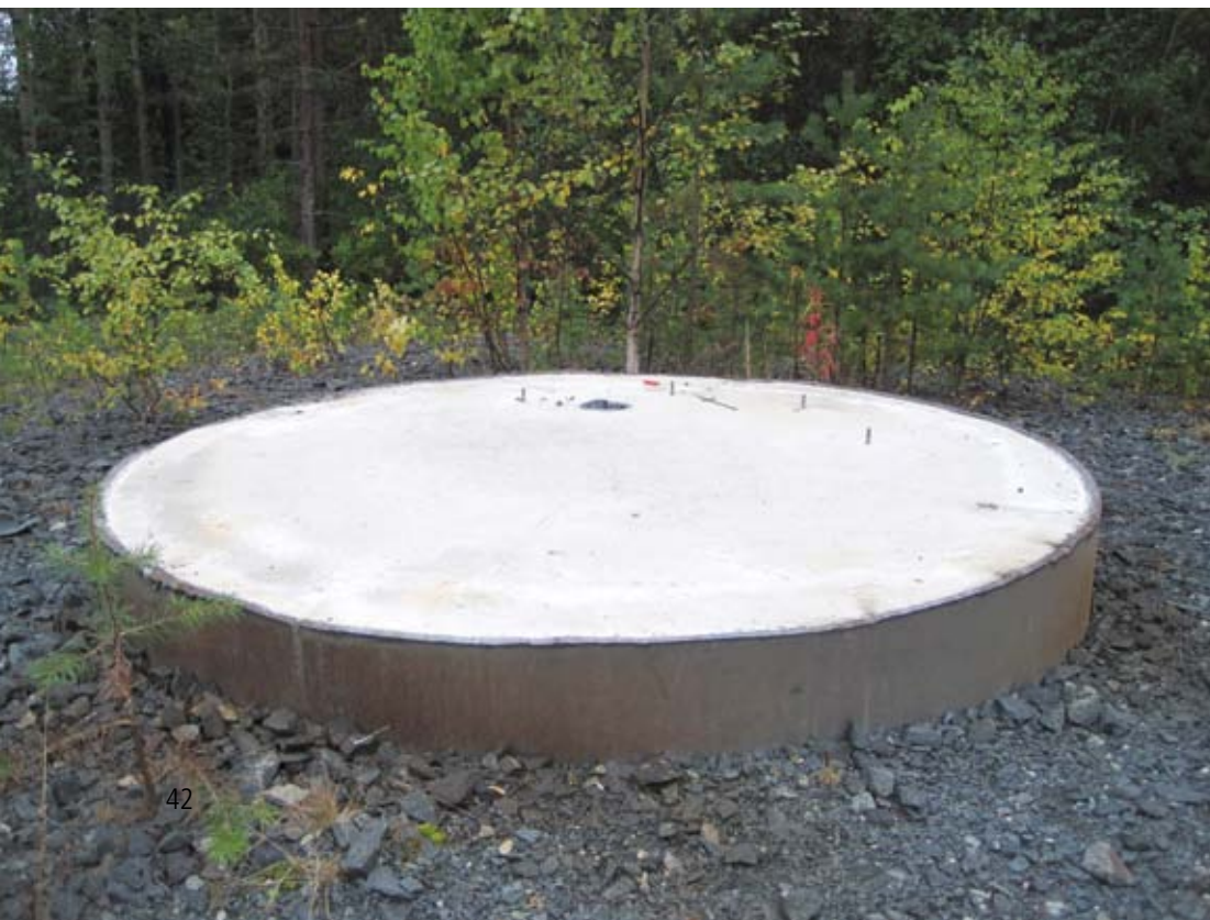
Kuva 6-3 Puretun voimalan perustukset.
