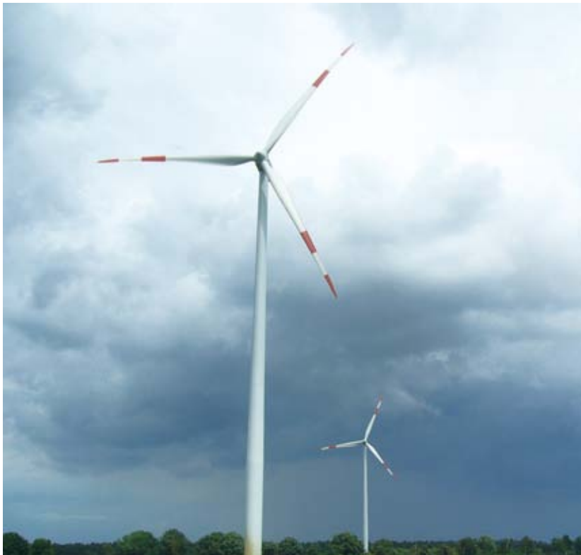
Kuva 3-7 Esimerkkikuva tuulivoimalan päivämerkinnöistä.
