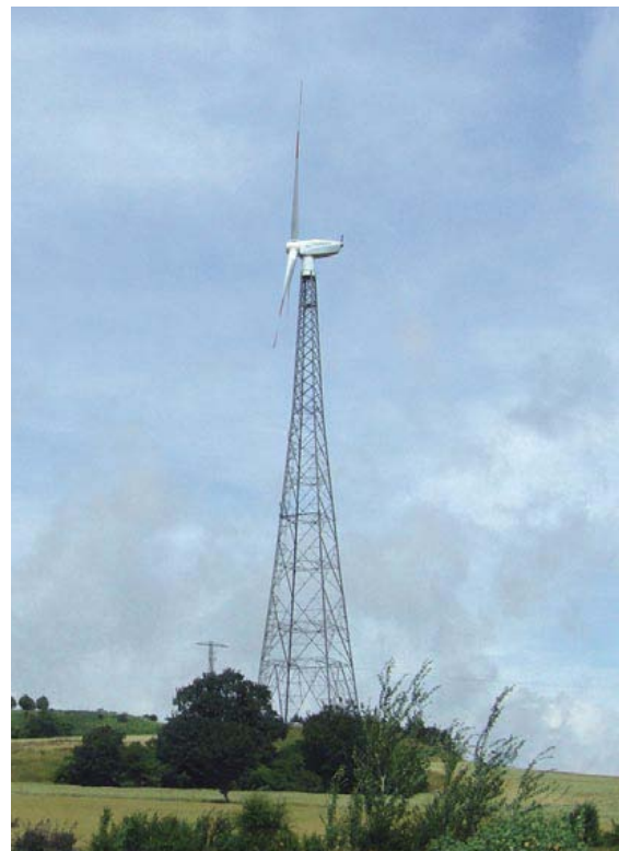
Figur 6-12 Torn av fackverkskonstruktion.
