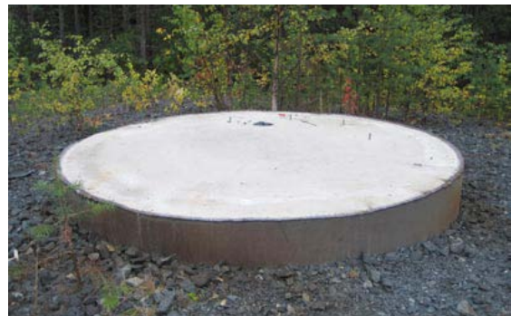
Figur 7-3 Fundament efter ett kraftverk som monterats ned.
