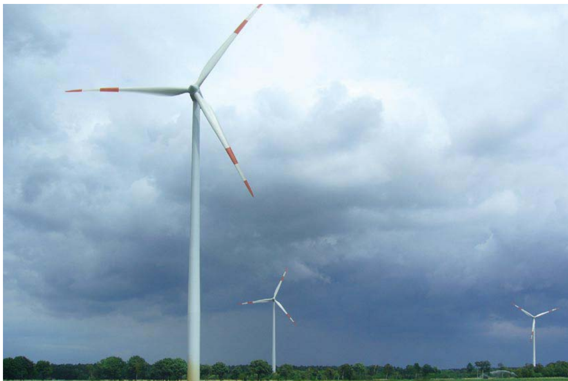
Figur 6-13 Exempel på dagmarkeringar på ett vindkraftverk.
