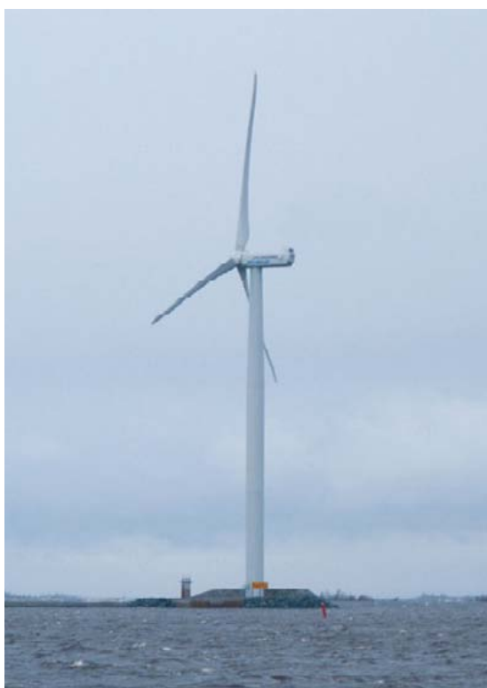
Kuva 6-6 Putkitorni.
