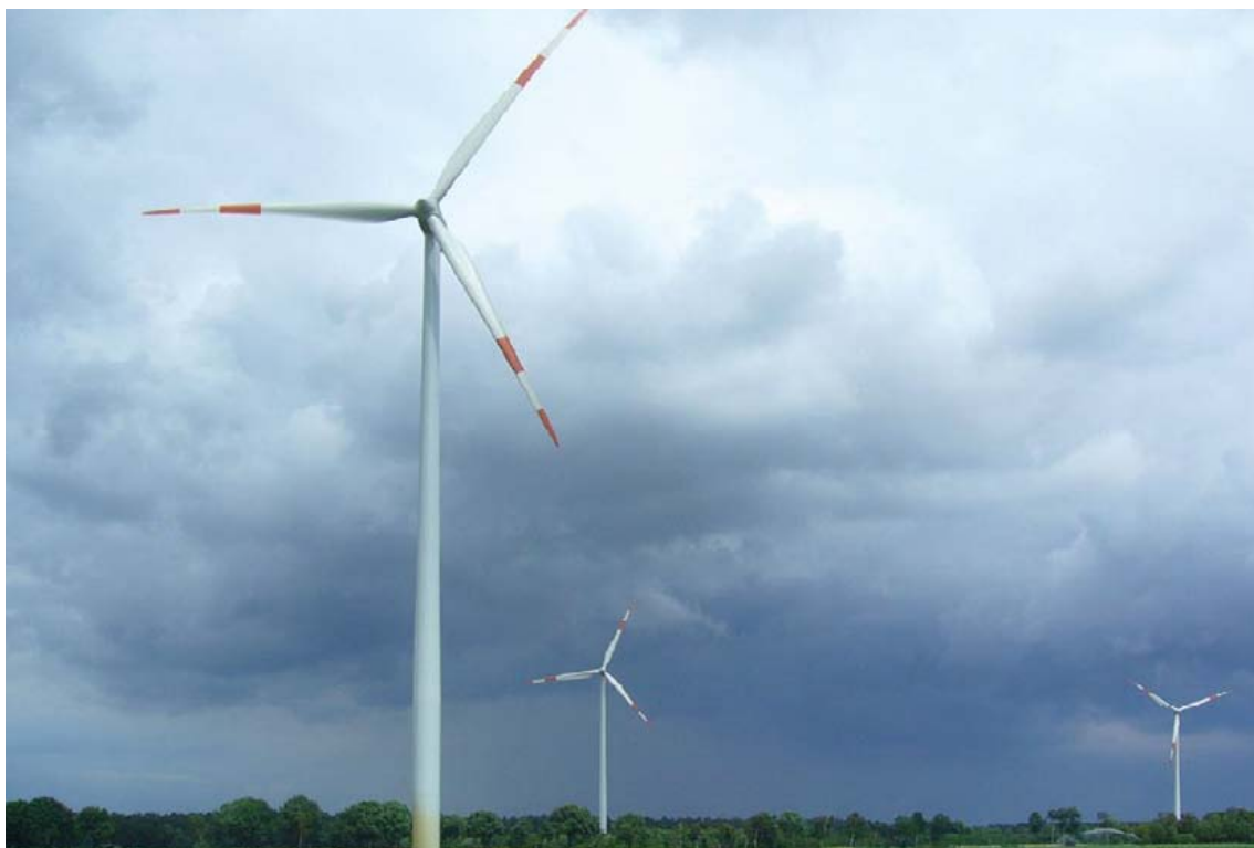
Kuva 6-8 Esimerkkikuva tuulivoimalan päivämerkinnöistä.
