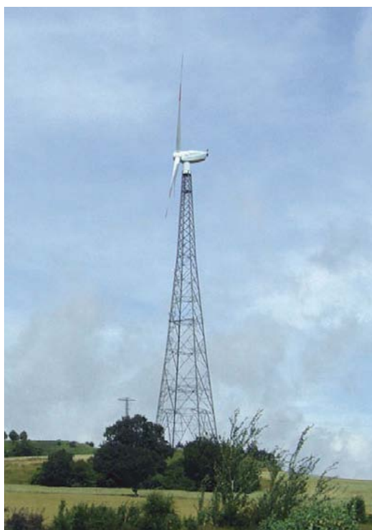
Kuva 6-7 Ristikkotorni
