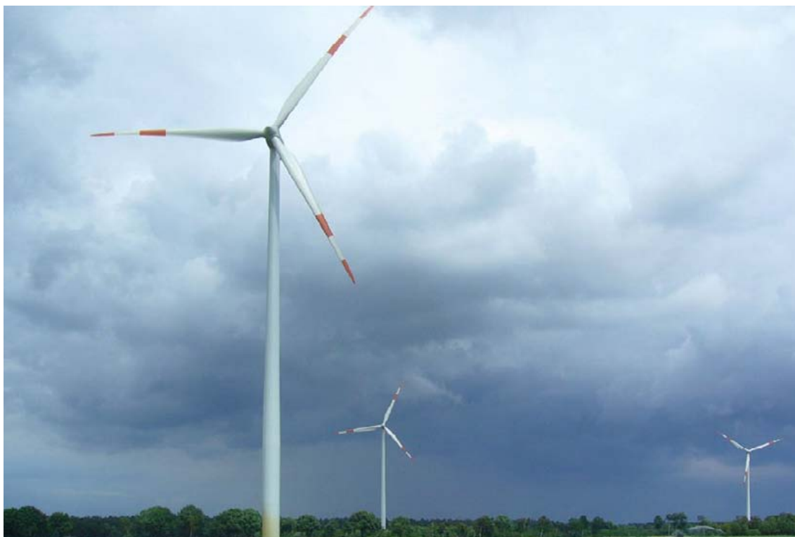
Figur 6-8. Exempel på dagmarkeringar på ett vindkraftverk.
