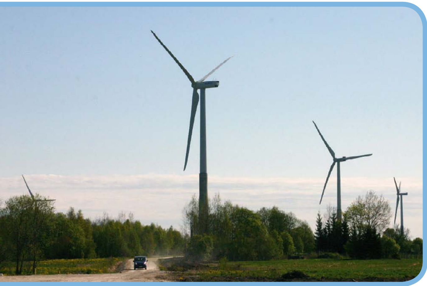
Figur 1-1. En vindkraftspark med omgivning på land.
