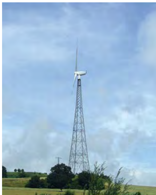
Kuva 6-7. Ristikkotorni
