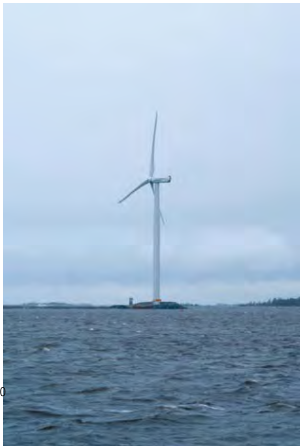
Kuva 6-6. Putkitorni
